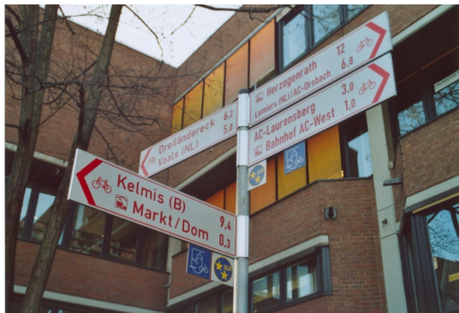
Abb. 3-20: Beispiel der Montagereihenfolge mehrerer Pfeilwegweiser, die in dieselbe Richtung weisen
