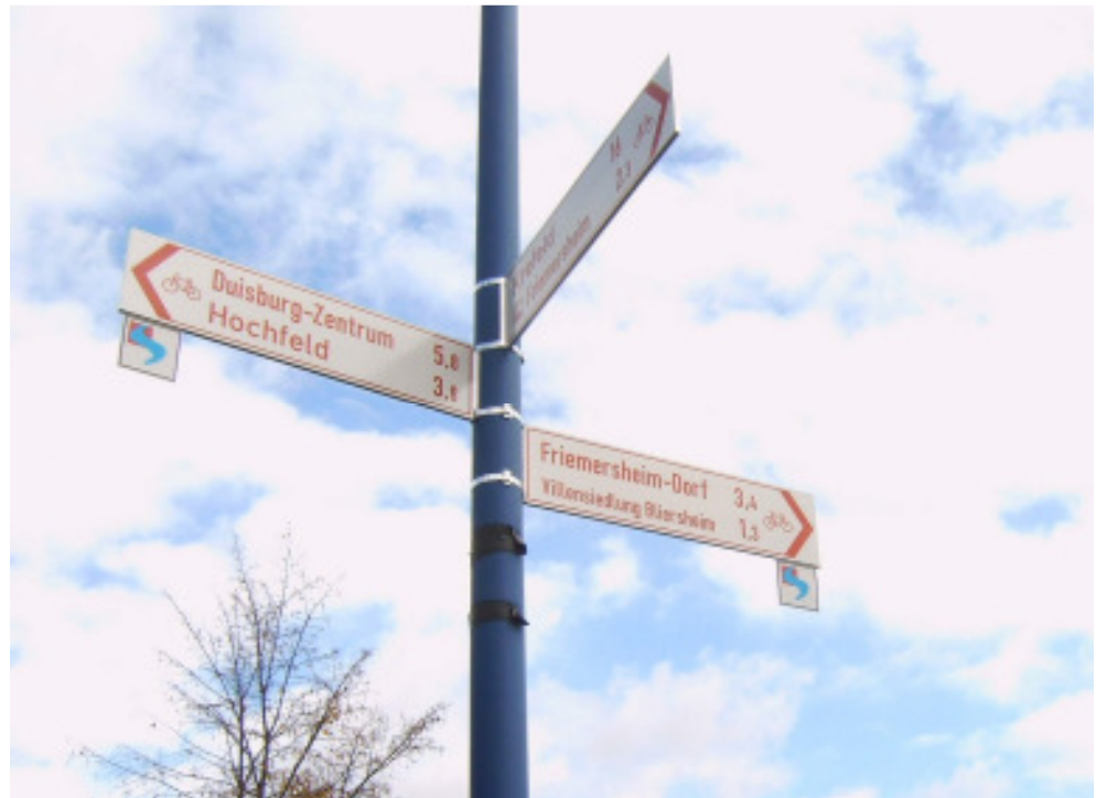
Abb. 3-33: Bessere Sichtbarkeit: Montage eines Wegweisers an Straßenleuchte
