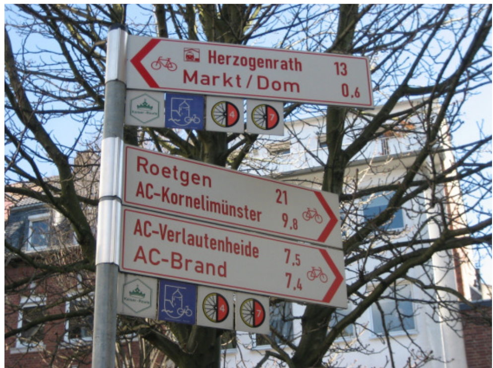
Abb. 3-39: An der Spitze montierter Pfeilwegweiser bei besonders beengten räumlichen Verhältnissen
