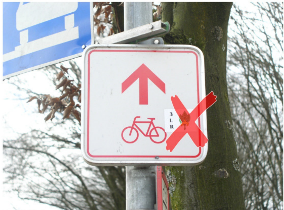
Abb. 3-16: Beispiel für unzulässige Integration von Routen auf Zwischenwegweisern (Mangel wurde inzwischen behoben).
