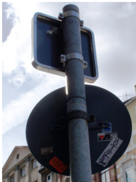
Abb. 3-36: Pfostenverlängerung
