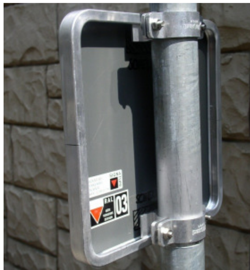
Abb. 3-41: Vandalismussichere Befestigung eines Zwischenwegweisers
