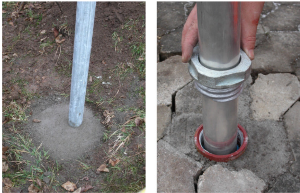
Abb. 3-37: Beispiele für Pfostenverankerung: Abb. links: Ortbetonfundament, Untergrund Erdreich; Abb. rechts: Bodenhülse, Untergrund Pflaster (Quelle: Landesbetrieb Mobilität Rheinland-Pfalz (Hrsg.): Hinweise zur wegweisenden und touristischen Beschilderung für den Radverkehr in Rheinland-Pfalz (HBR), Loseblattsammlung, Stand 01/2011. Fotos: Planungsbüro Mehrens)
