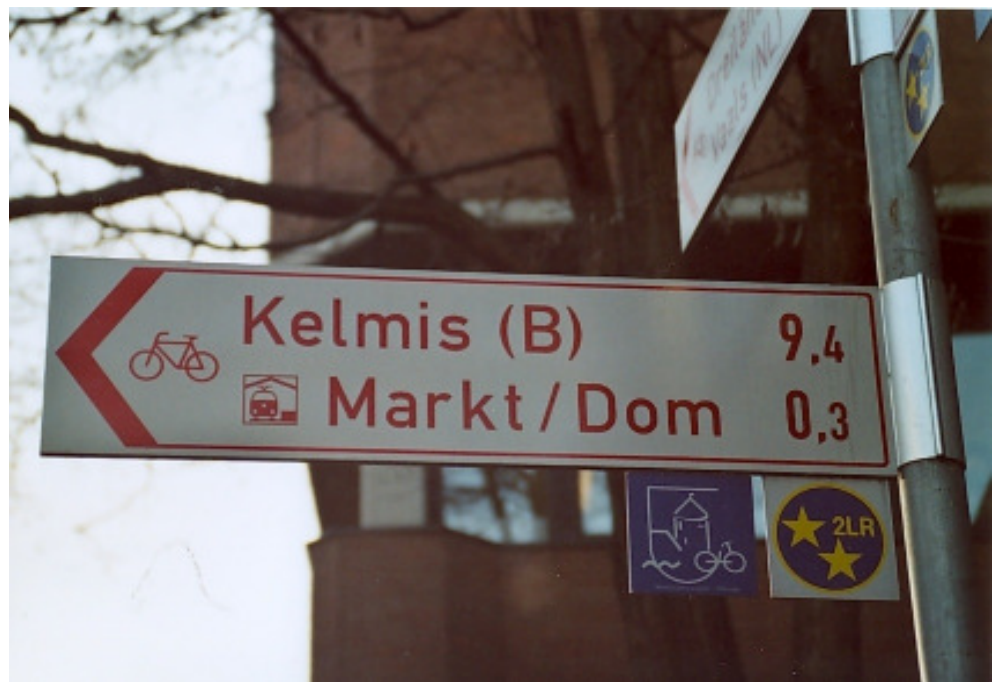
Abb. 3-7: Pfeilwegweiser mit Routeneinschüben
