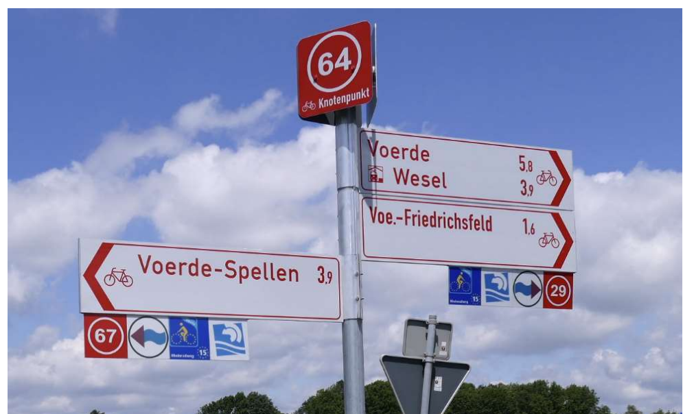
Abb. 3-8: Beispiel der Montagereihenfolge mehrerer Pfeilwegweiser, die in dieselbe Richtung weisen (Quelle: SVK)
