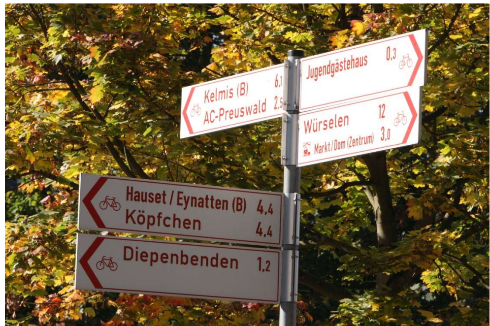
Abb. 3-39: Montagehöhe mehrerer Pfeilwegweiser am selben Pfosten (Quelle: SVK)
