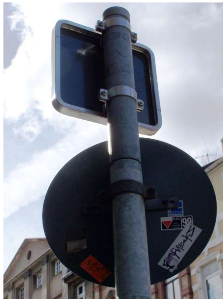
Abb. 3-35: Pfostenverlängerung (Quelle: SVK)
