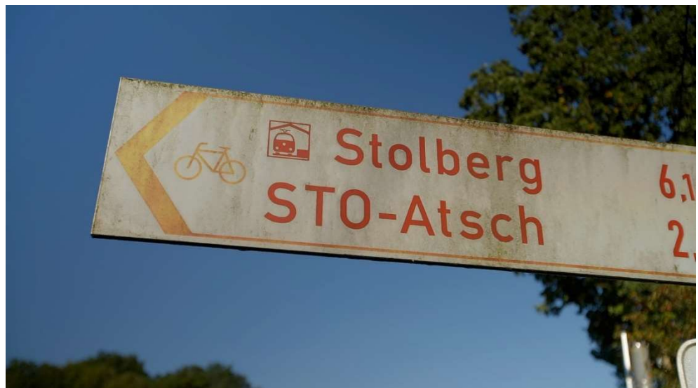
Abb. 6-3: Wartungsbedürftiger Wegweiser (Quelle: WeishauptFilm)
