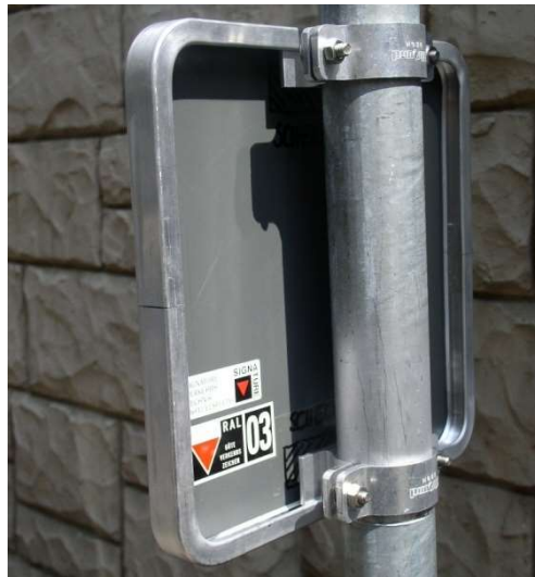
Abb. 3-40: Vandalismussichere Befestigung eines Zwischenwegweisers (Quelle: SVK)
