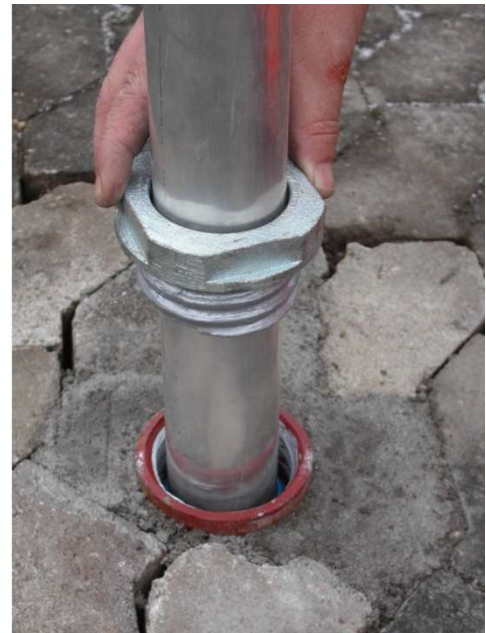
Abb. 5-5: Beispiele für Pfostenverankerung: Abb. links: Ortbetonfundament, Untergrund Erdreich; Abb. rechts: Bodenhülse, Untergrund Pflaster (Quelle: Landesbetrieb Mobilität Rheinland-Pfalz (Hrsg.): Hinweise zur wegweisenden und touristischen Beschilderung für den Radverkehr in Rheinland-Pfalz (HBR), Loseblattsammlung, Stand 01/2011. Fotos: Planungsbüro Mehrens)
