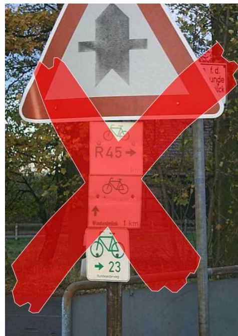
Abb. 4-2: Beispiele für Befestigungen von Wegweisern in Kombination mit StVO-Schildern: Abb. links - verboten / Abb. rechts – zulässig (Quelle: IVV)
