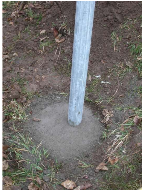
Abb. 5-5: Beispiele für Pfostenverankerung: Abb. links: Ortbetonfundament, Untergrund Erdreich; Abb. rechts: Bodenhülse, Untergrund Pflaster (Quelle: Landesbetrieb Mobilität Rheinland-Pfalz (Hrsg.): Hinweise zur wegweisenden und touristischen Beschilderung für den Radverkehr in Rheinland-Pfalz (HBR), Loseblattsammlung, Stand 01/2011. Fotos: Planungsbüro Mehrens)
