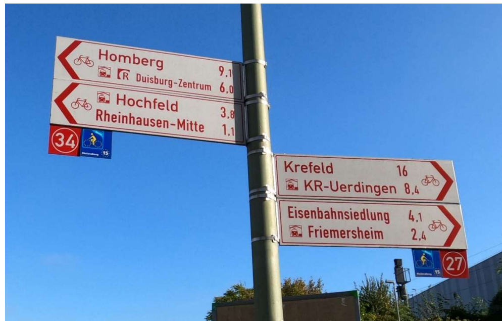
Abb. 3-32: Bessere Sichtbarkeit: Montage eines Wegweisers an Straßenleuchte (Quelle: IVV)
