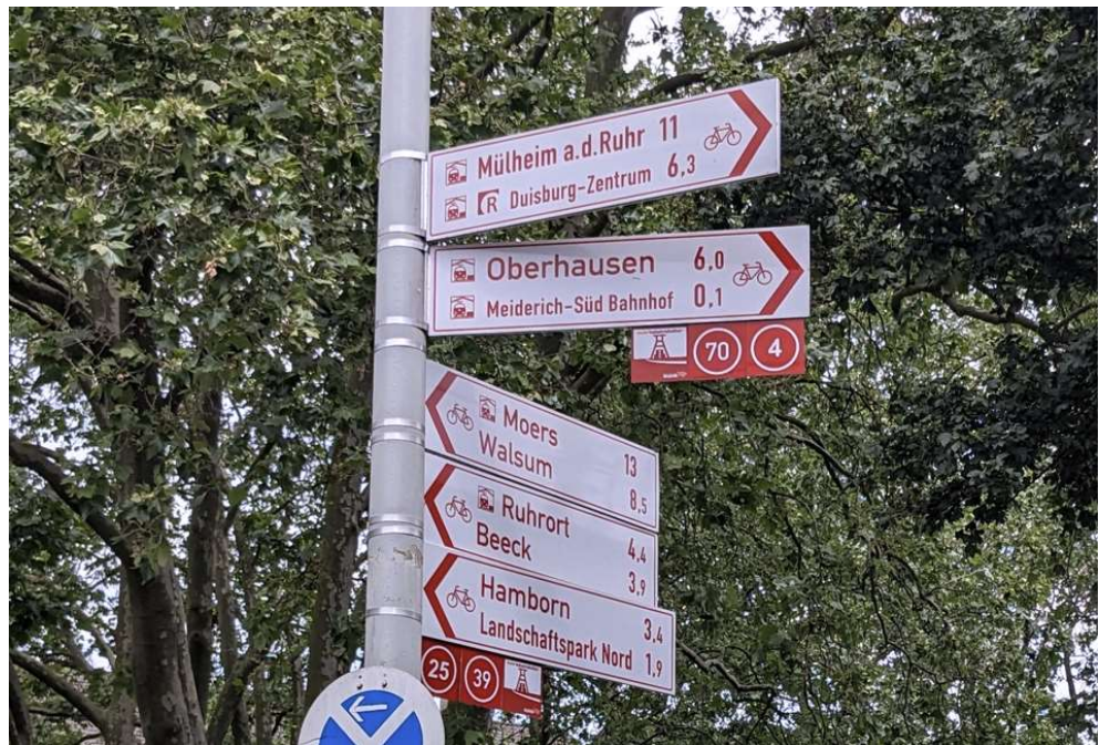
Abb. 3-38: An der Spitze montierter Pfeilwegweiser bei besonders beengten räumlichen Verhältnissen (Quelle: SVK)
